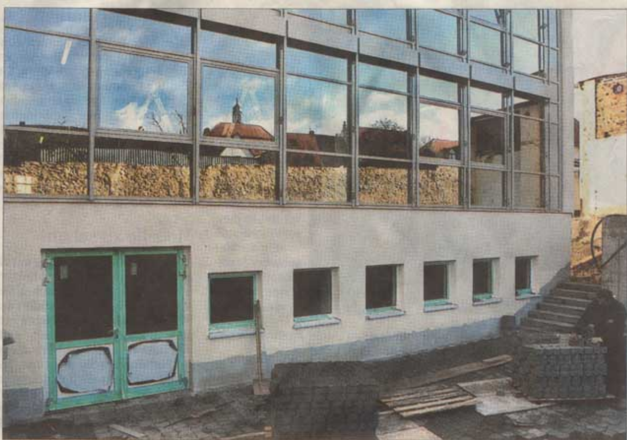
Die gläserne Fassade des Neubaus der Videotronic GmbH vom Westen aus gesehen. Bei schönem Wetter spiegelt sich darin die Querfurter Altstadt.
